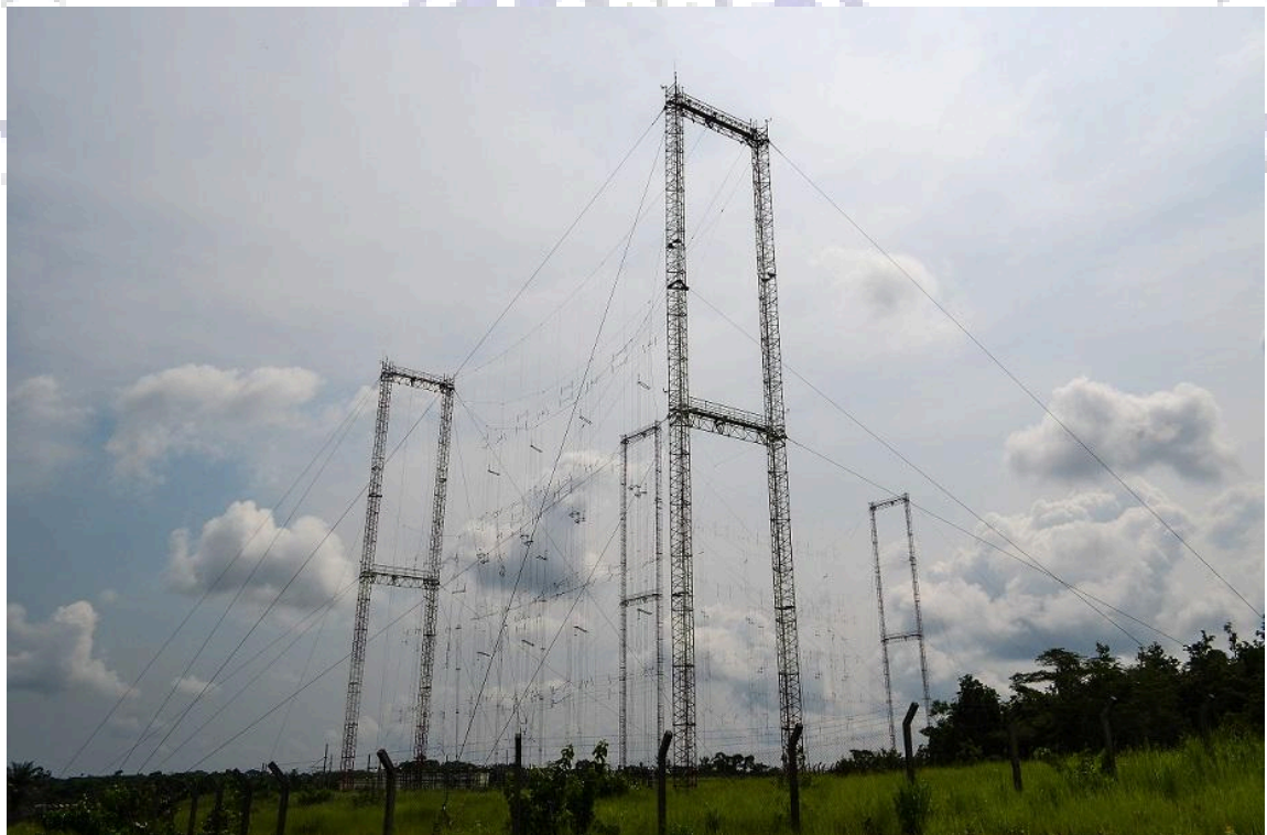
Imagem: A poderosa cortina de antenas dipolo do centro de transmissão em Moyabi, da Rádio África Nº1, vista de outro ângulo, aqui podemos observar as torres na sua totalidade, formando assim uma cruz, com a finalidade de direcionar a potência irradiada para os 4 pontos cardeais (Fotografia de Jean Baptiste Dodane)
